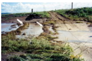
Un 2-m courant d'eau de l'inondation est passé cette "traversée Irlandaise" sur une ferme en Australie. Les haies de Vétiver ont été plantées à l'amont et sont adjacentes à la traversée, et comme résultat, la vitesse élevée de l'eau de l'inondation était incapable à filer et casser le béton (dans les inondations antérieures, la traversée a été détruite sans protection du vétiver et reconstruite). Photo par Paul Truong
