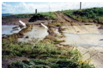
2 m de fluxo da enchente sobre "Irish Crossing" em uma fazenda na Austrália. Cercas Vetiver foram plantadas a montante e próximo da passagem e como resultado a alta velocidade da água foi incapaz de destruir o concreto (na enchente prevista, sem proteção vetiver a passagem foi destruída e reconstruída). Foto de Paul Truong
