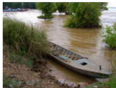
Abaixo: a planície de inundação do rio não cria nenhum dano ao banco do rio plantado com o vetiver (à esquerda)
