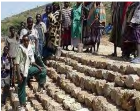
Barrages de stockage des sédiments en construction (Ethiopie) Daniel Danano, NR de l'Ethiopie ethiocat@ethionet.et
