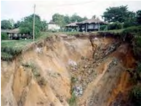
Tête de ravine menaçants des bâtiments publics (RD du Congo) Paul Truong, Réseau Vétiver, Brisbane, Australie. truong@uqconnect.net
