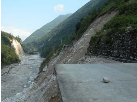
Flujo de escombros destruyendo una ruta en Hailuo Gully National Park , por Cui Peng , Institute of Mountain Disaster and Environment, Chengdu, China. pengcui@imde.ac.cn
